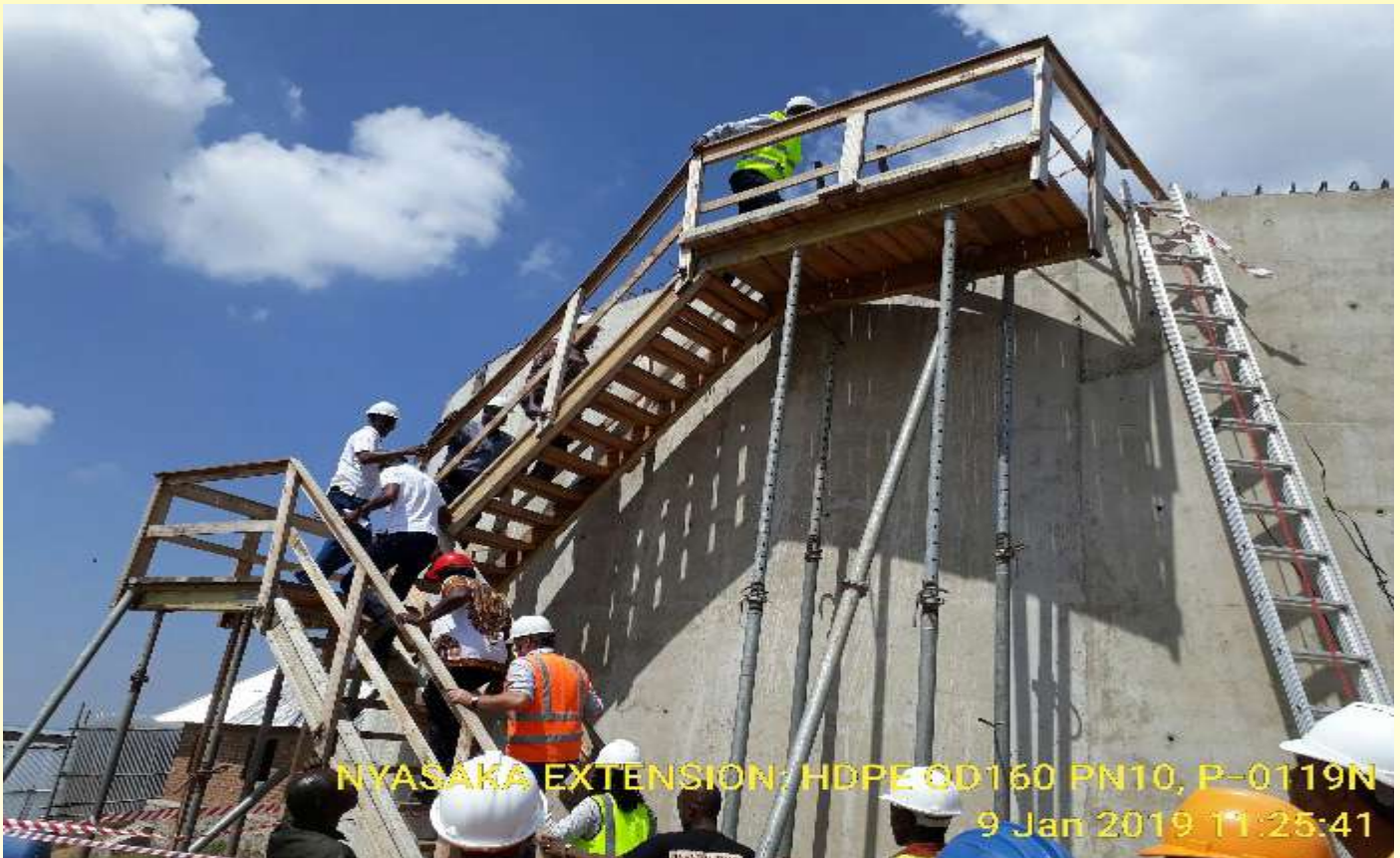
Naibu Waziri wa Maji Mhe. Jumaa Aweso akikaguwa ujenzi wa tanki la Maji eneo la Nyasaka
