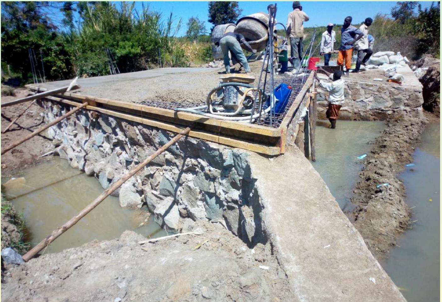
Ujenzi wa daraja la barabara mpya ya Igogwe Sangabuye Km 9.3 barabara iliyojengwa na mfuko wa Jimbo na taasisi ya Angeline Foundation
