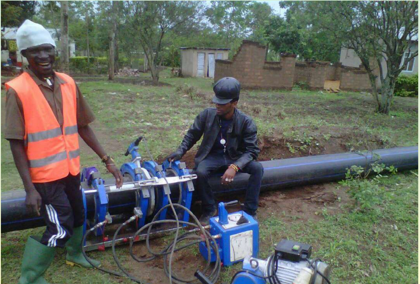
Mafundi wakiendelea na zoezi la kulaza mabomba katika mradi mkubwa wa maji unaosimamiwa na MWAUWASA
