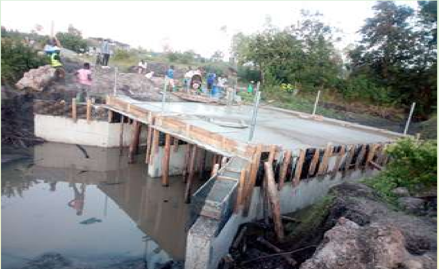
Ujenzi wa daraja la Kashishi Kata ya Nyamhongolo linalounganisha Wilaya ya Ilemela na Nyamagana unaendele kwa kasi
