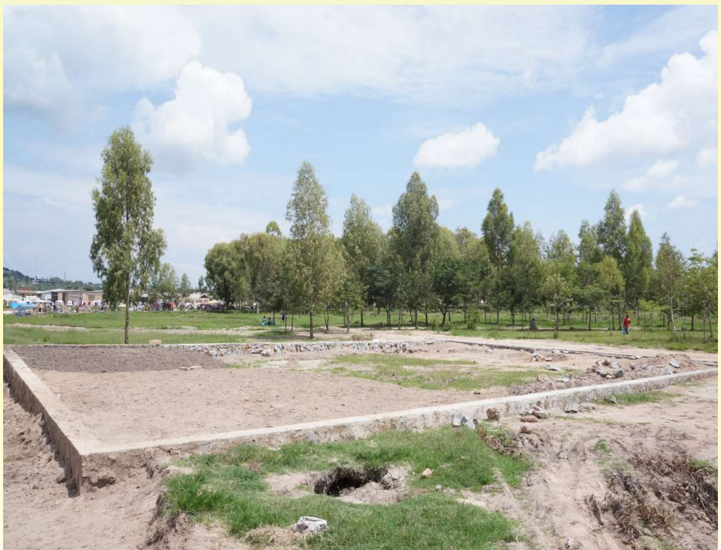
Uwanja wa mpira wa pete ukiwa katika hatua za mwanzo wa ujenzi eneo la Sabasaba
