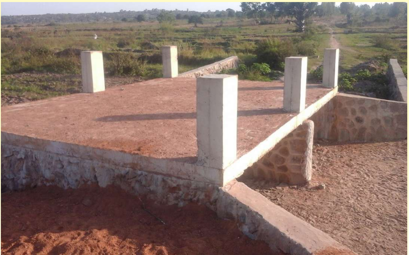
Ujenzi wa daraja katika barabara mpya ya Kahama - Iponyabugali Km 18.9 barabara iliyojengwa na mfuko wa Jimbo na taasisi ya Angeline Foundation
