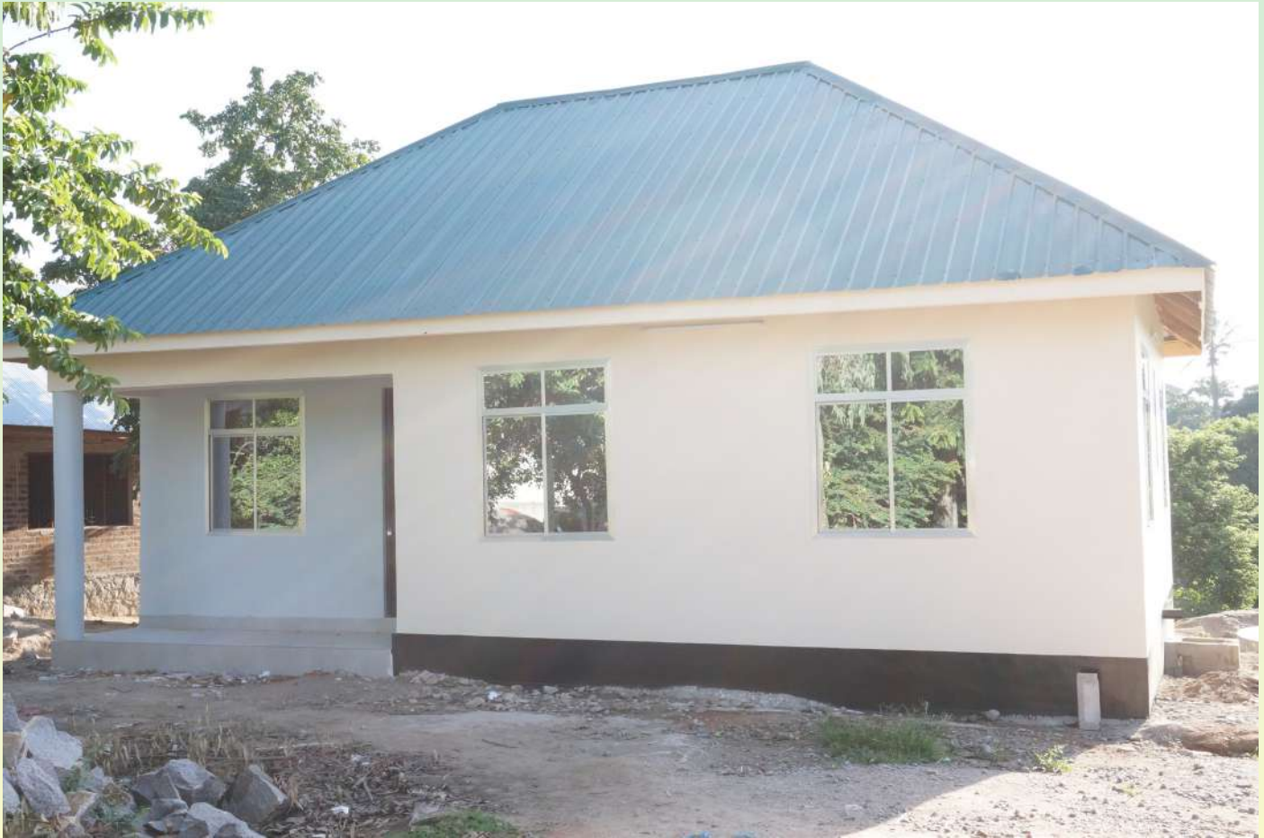
Moja ya nyumba ya mtumishi iliyojengwa katika kituo cha afya Buzuruga, ikiwa ni hatua ya Manispaa kuboresha makazi ya watumishi.
