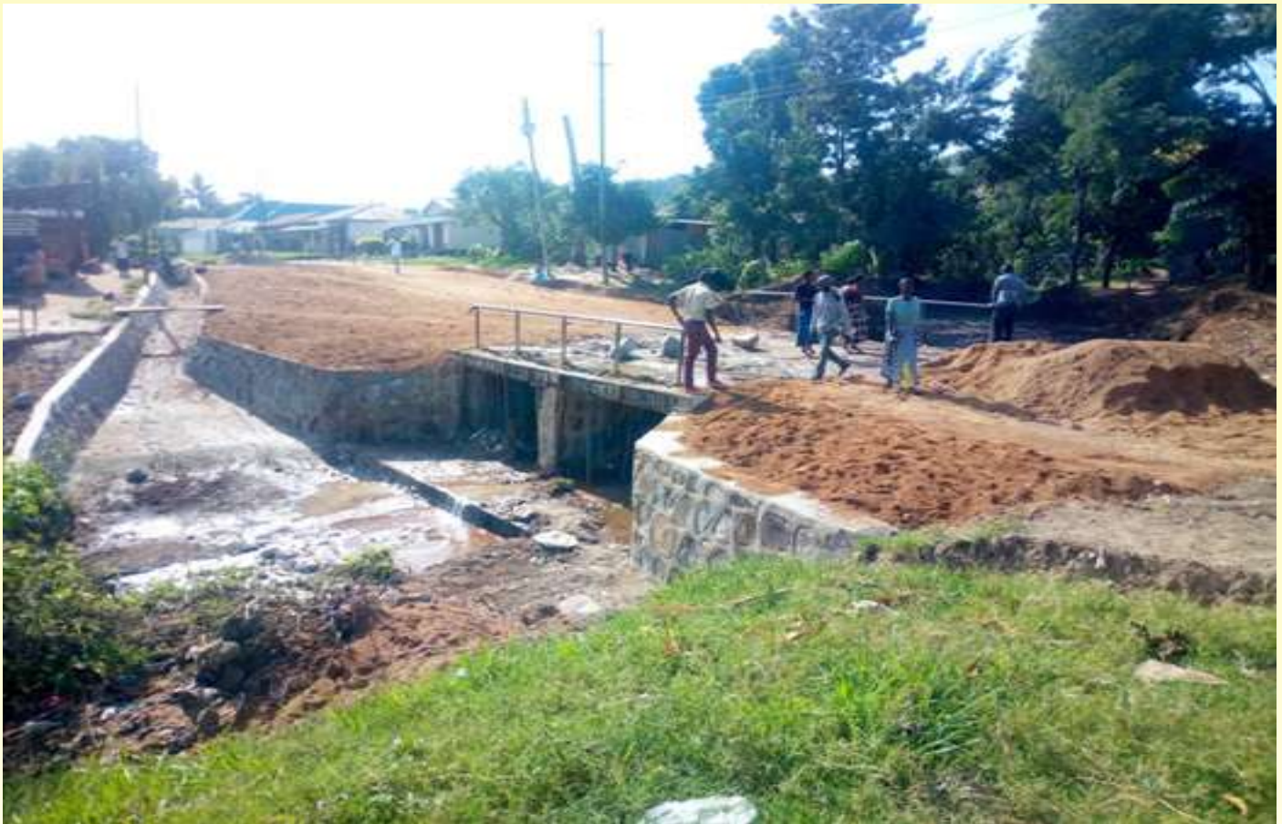
Ujenzi wa daraja la Bigbite kata ya Ibungiro unaendelea kwa kasi.
