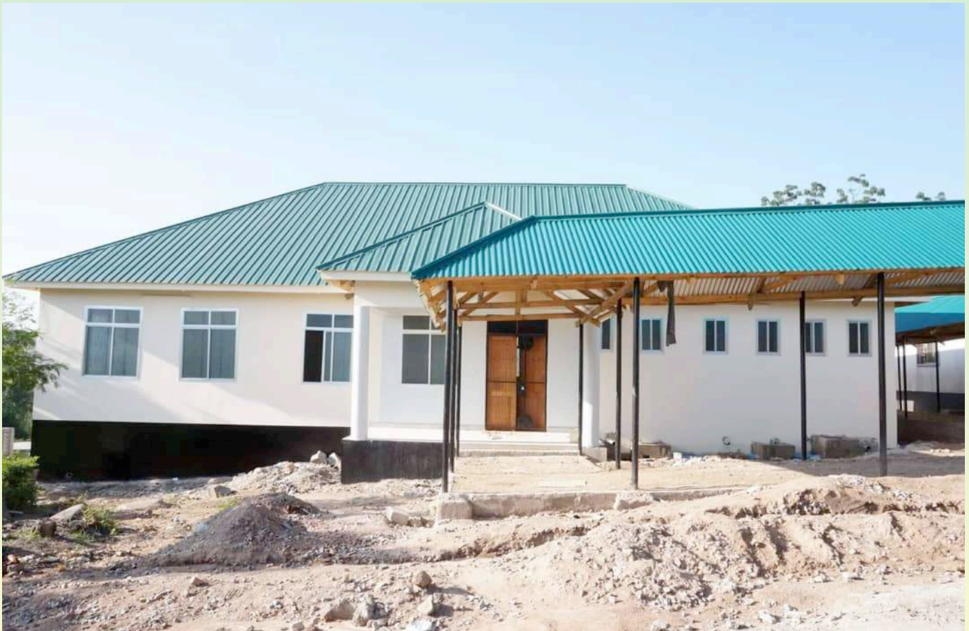
Jengo jipya la Maabara katika kituo cha Afya Buzuruga, Manispaa ya Ilemela ambalo lipo katika hatua za mwisho za ukamilishwaji kwa ajili ya kuanza kutoa huduma kituoni hapo.
