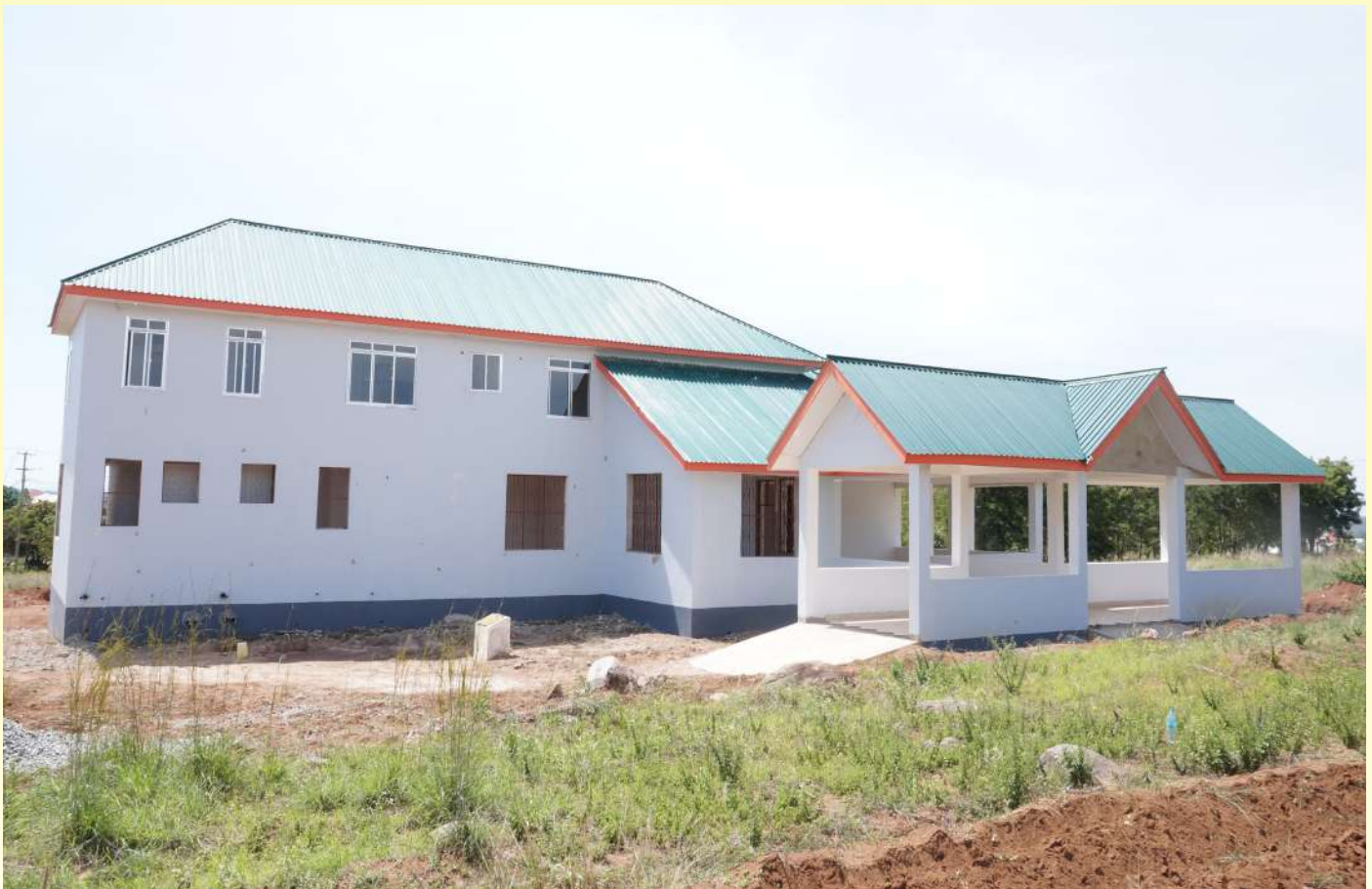
Sehemu ya mbele ya jengo la wagonjwa wa nje ya iliyokusudiwa kuwa hospitali ya wilaya Jengo limekamilika kwa asilimia 100, kwa sasa hospital inajengwa eneo la Isanzu Kata ya Bugogwa.
