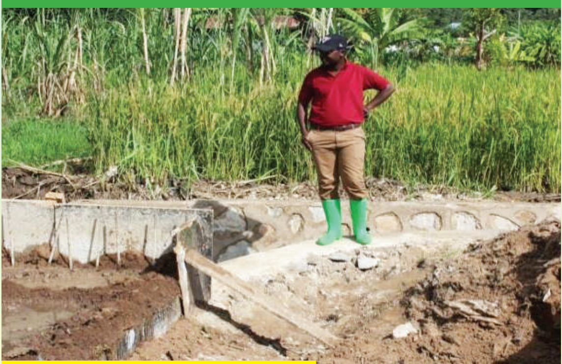
Katibu wa Mbunge Ndg Kheri D. James akikagua ujenzi wa moja ya barabara katika Kata ya Pasians
