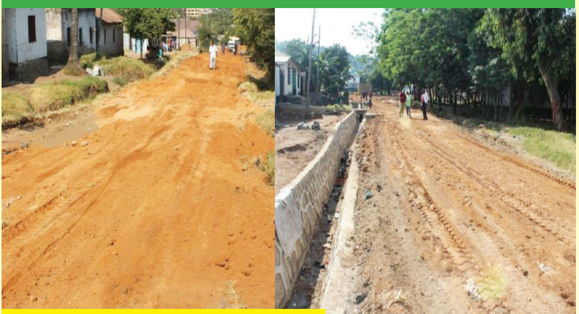
Ujenzi unaendelea vyema kuhakikisha miundombinu yote ya barabara inapitika wakati wote, katika Kata ya Kirumba Mtaa wa Kiyungi
