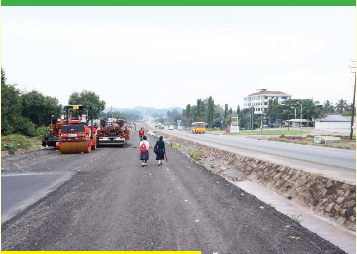
Ujenzi wa barabara ya lami kuanzia Makongoro hadi Aoirport njia nne yenye Km 5.6 unaendelea kwa kasi kubwa
