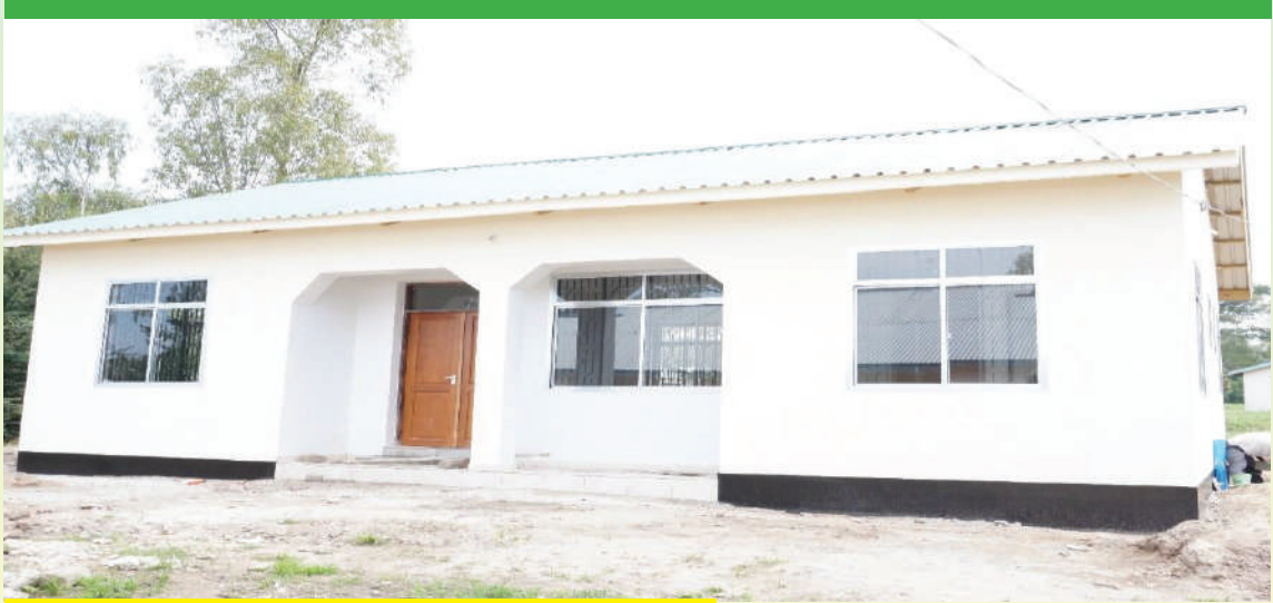
Nyumba ya mtumishi iliyojengwa katika kituo cha afya Karume
