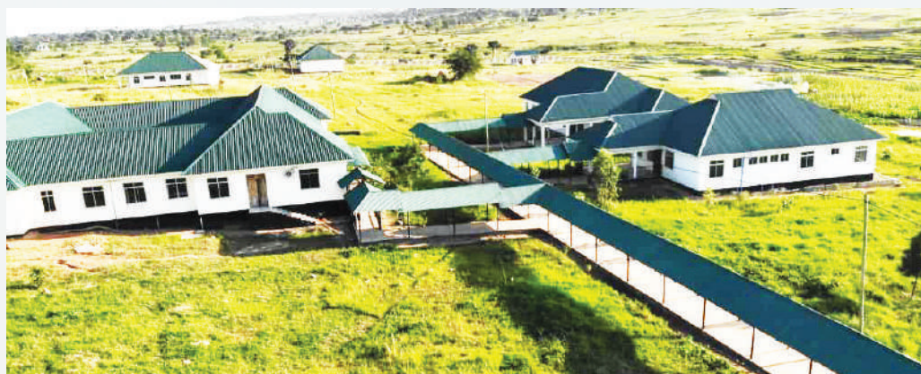
Sehemu ya majengo ambayo yamekamilika katika Hospital ya wilaya ya Ilemela, ujenzi wa miundombinu bado unaendelea.
